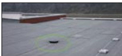
Slika 8: poškodba hidroizolacije ravne strehe.
