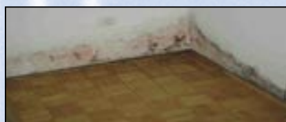
Slika 2: prikaz podhlajene in vlažne stene
