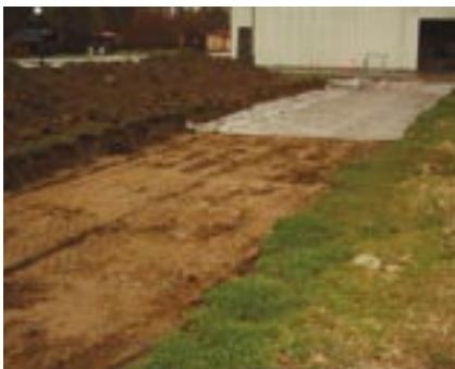
Slika 1: Preizkusno polje – polaganje geosintetika Typar ® SF 40
