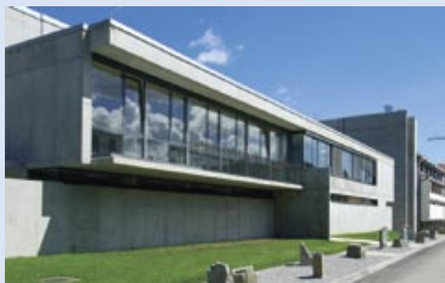
Slika 2: Pogled na srednjo gradbeno šolo s severa
