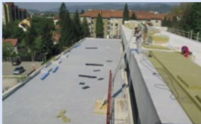
Slika 3: Materiala na strehi TPO (termoplastični poliolefin) Sintofoil ST (d = 1,2 mm, siva barva) in toplotna izolacija iz kamene volne Rockwool Roofrock (d = 50 mm + 100 mm)
