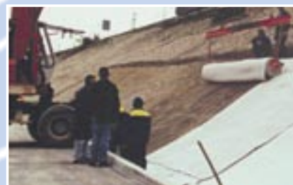
Slika 6: raba tesnilnih geosintetikov strmo narašča, ne le zaradi čedalje strožjih okoljevarstvenih standardov, temveč tudi zaradi hudega pomanjkanja naravnih glin.
