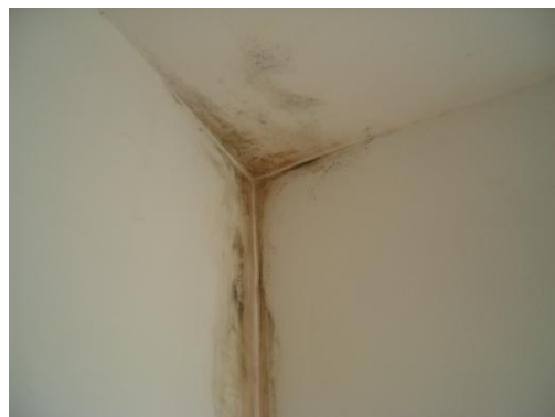
Fotografiji 6-7: Pojav zidne plesni, kot posledica toplotnih mostov in kondenzacije vlage
