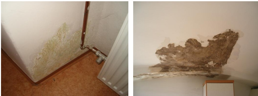
Fotografiji 10-11: odstopanje materiala, kot posledica kapilarnega vleka vlage
