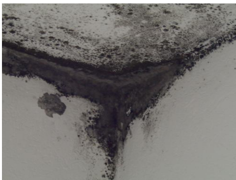
Fotografiji 6-7: Pojav zidne plesni, kot posledica toplotnih mostov in kondenzacije vlage
