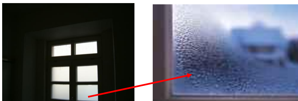
Fotografiji 4-5: kondenzacija vlage na okenskih steklih
