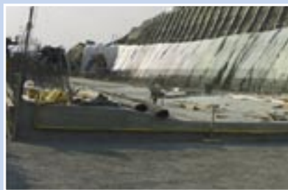
Slika 4: značilen primer rabe geosintetika za zaščito neobstojne flišne kamnine v času gradnje.
