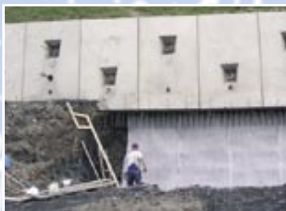
Slika 3: raba drenažnih geokompozitov pri gradnji sidranih opornih konstrukcij na AC Trojane – Blagovica po sistemu od zgoraj navzdol. V tako zahtevnih konstrukcijah bi bila raba klasičnih drenažnih zasipov izjemno zamudna in zapletena.
