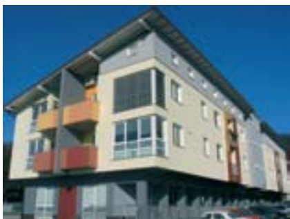
Barviti balkoni polepšajo fasado objekta
