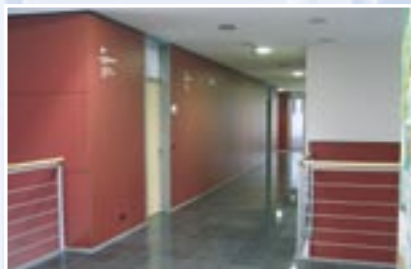
Slika 2: upravna zgradba Komunala Ptuj
