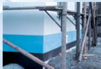
Slika 4: Tipičen primer uporabe pene XPS na zidnih površinah tik nad tlemi (Fotografija: Dow Building Solutions)
