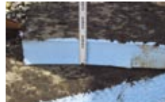
Slika 12: V prečnem prerezu je plošča ROOFMATE praktično gradbeno suha.
