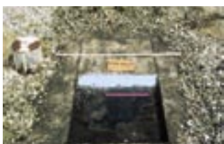
Slika 9: Odstranitev plošče ROOFMATE.
