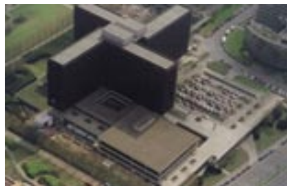
Slika 1: Pogled na streho upravne stavbe Hamburg-Mannheim.
