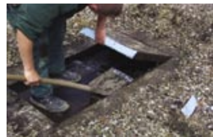
Slika 4: Odstranitev 32 let stare plošče ROOFMATE.
