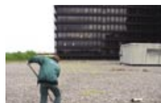
Slika 15: Staro ploščo ROOFMATE smo nadomestili z novo in jo ponovno prekrili s prodom.
