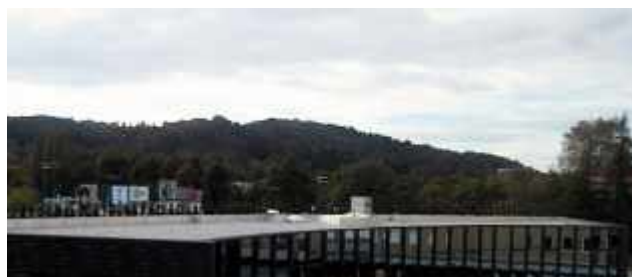
Obrnjena ravna streha na Poslovnem objektu Lev
