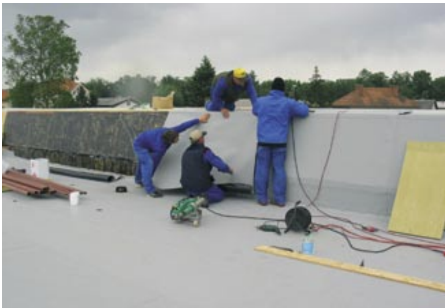
Slika 1: Obdelava atike s Sintofoil folijo na ravni strehi
