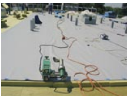
Slika 2: Polaganje Sintofoil folije na ravni strehi
