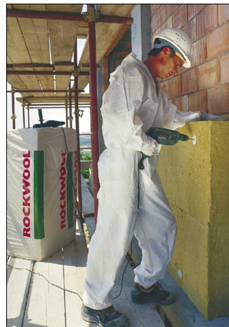
Vgradnja Rockwoolove kamene volne
